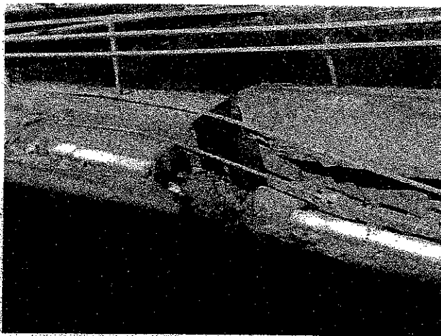
VISTA DO AFASTAMENTO DAS PAREDES DO VALÃO E AFUNDAMENTO DO LOGRADOURO.
