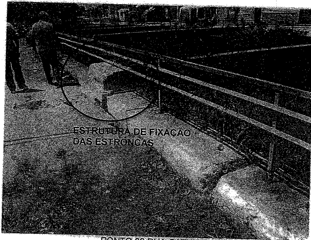
Figura 15 – Estrutura de Fixação das Estroncas localizada na rua Catumbi
