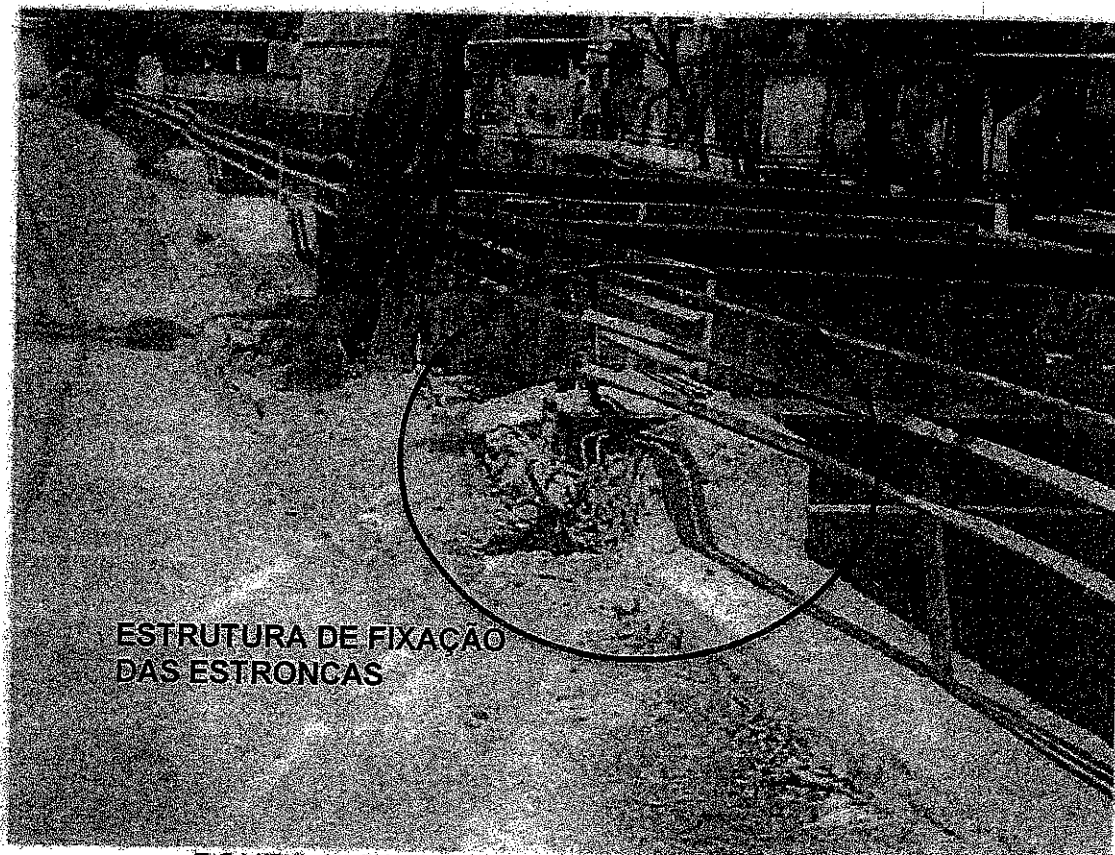
Figura 18 – Estrutura de Fixação das Estroncas localizada na rua do Chumbo e Rua Diamante
