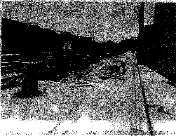
3º PONTO - FOTO DO RECALQUE DA RUA PROVOCADO PELO DESLOCAMENTO TOTAL DA CONTENÇÃO.
